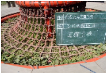
大型複合遊具点検①
