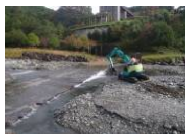
土砂撤去作業
